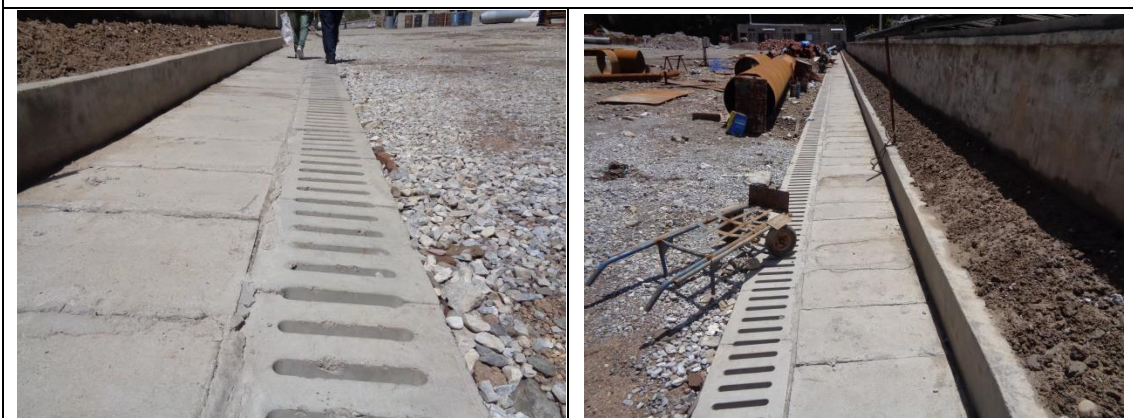
现场排水沟情况
