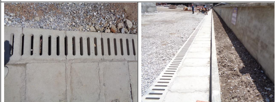
现场排水沟情况
