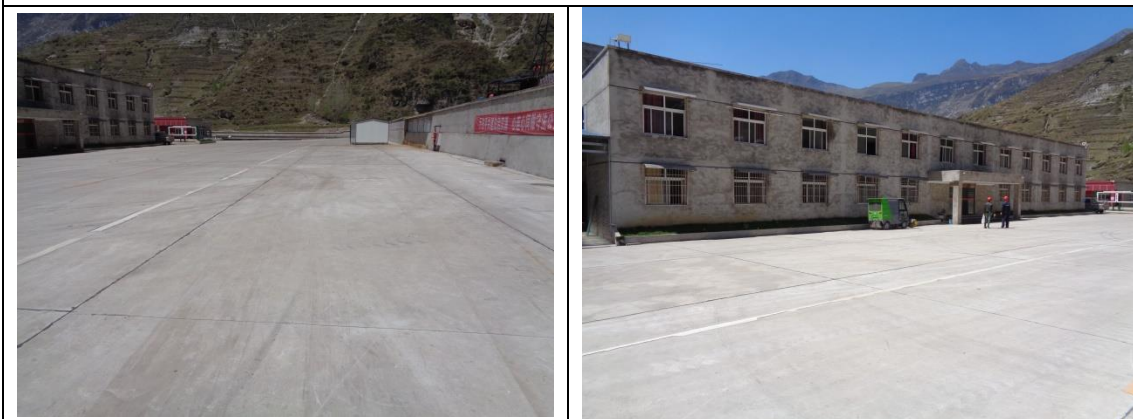
现场占地硬化情况
