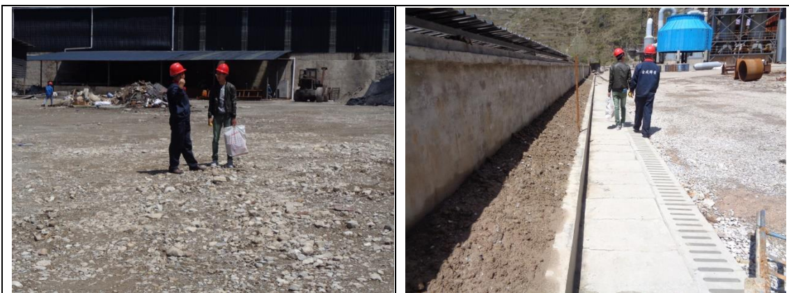
现场监测情况
