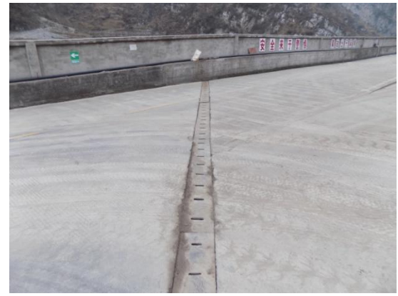
厂区内排水沟
