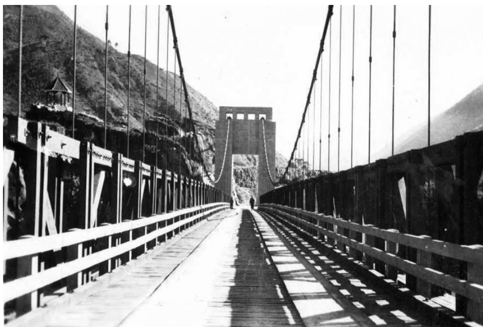
乐西公路大渡河悬索桥
