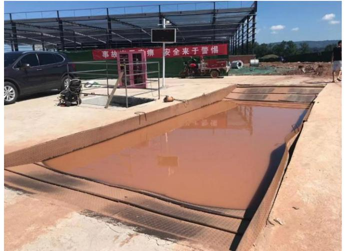
图 4 项目区内洗车凹槽
